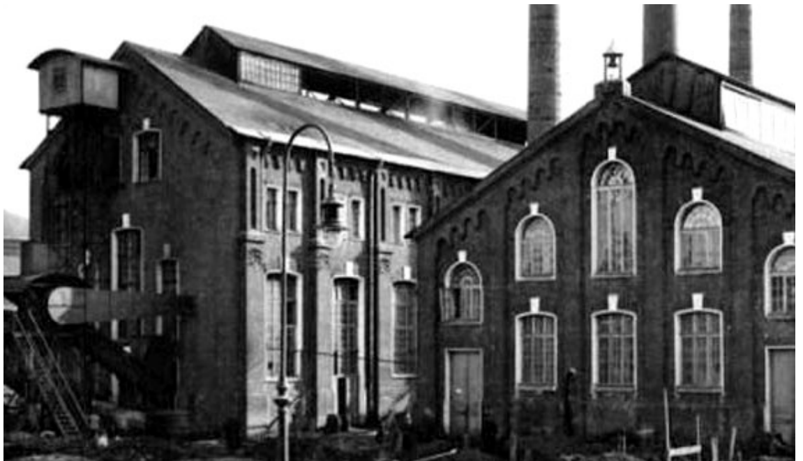
Рисунок 2. Применение фонаря верхнего света в промышленном здании.
