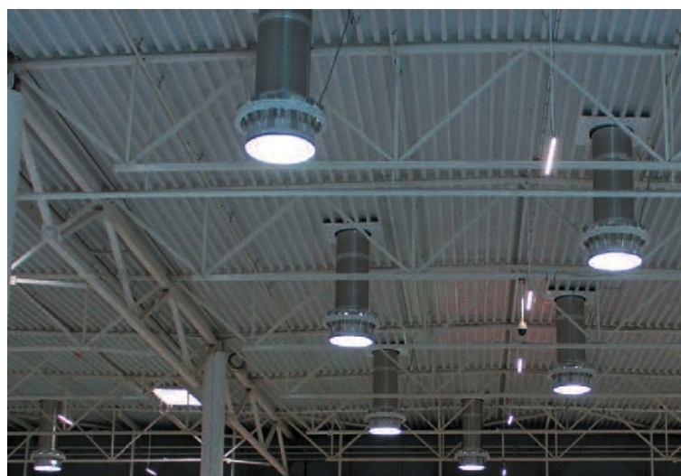
Рисунок 6. Пример применения полых трубчатых световодов в здании.
