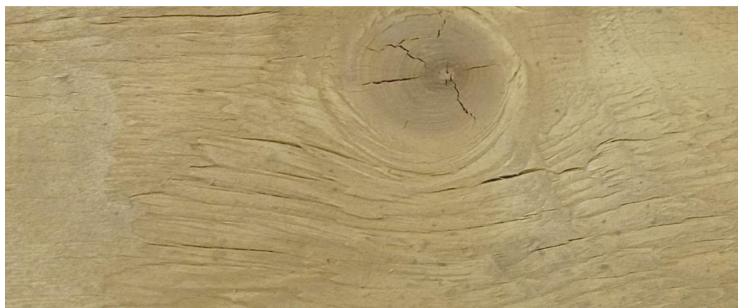
Рис. 2. Трещины в наружных слоях LVL
