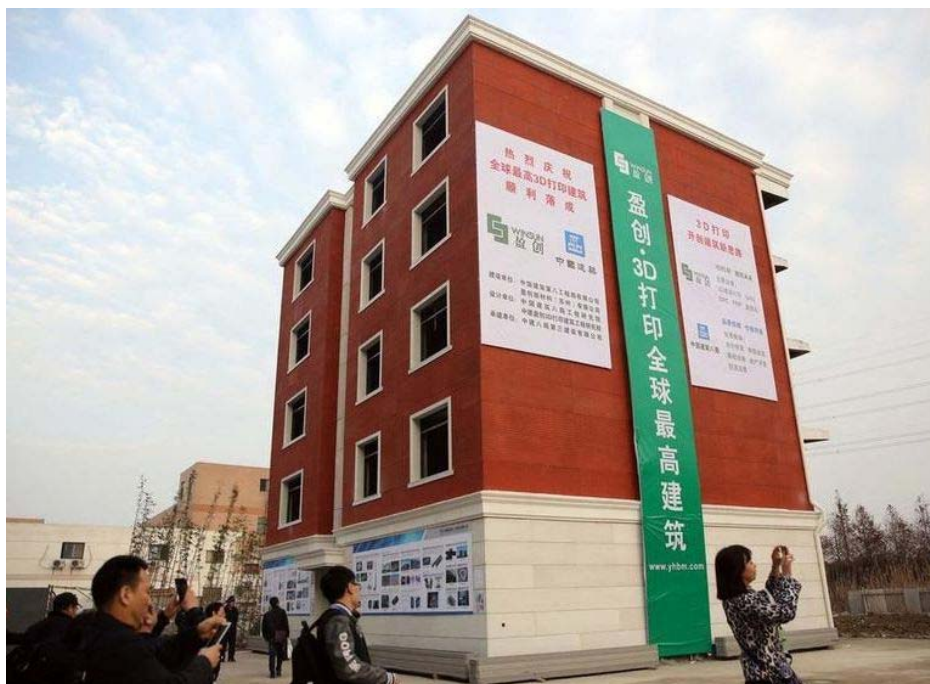
Рис. 1 – Пятиэтажное здание, напечатанное на 3D-принтере.
