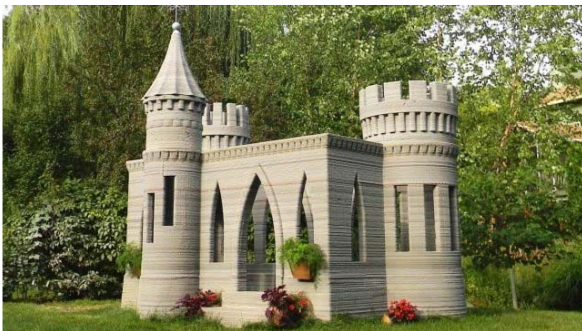
Рис. 2 - Первая конструкция напечатанная на месте
