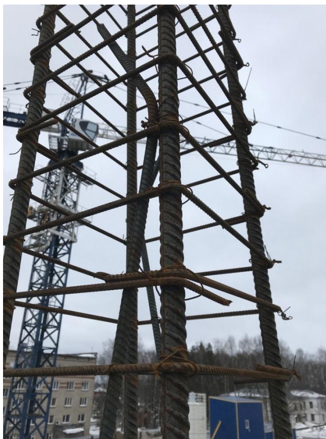
Рис. 2. – Вязка арматурного каркаса
