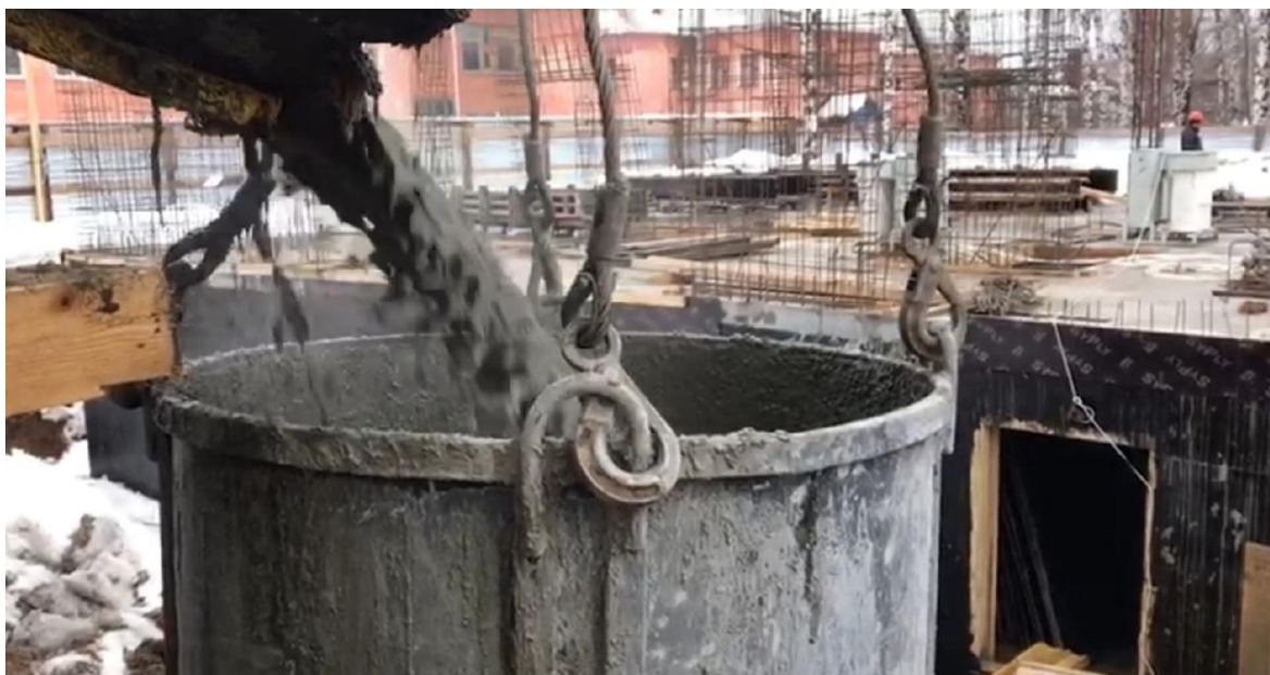
Рис. 3. – Работа бетонного завода «Флагман – 30»
