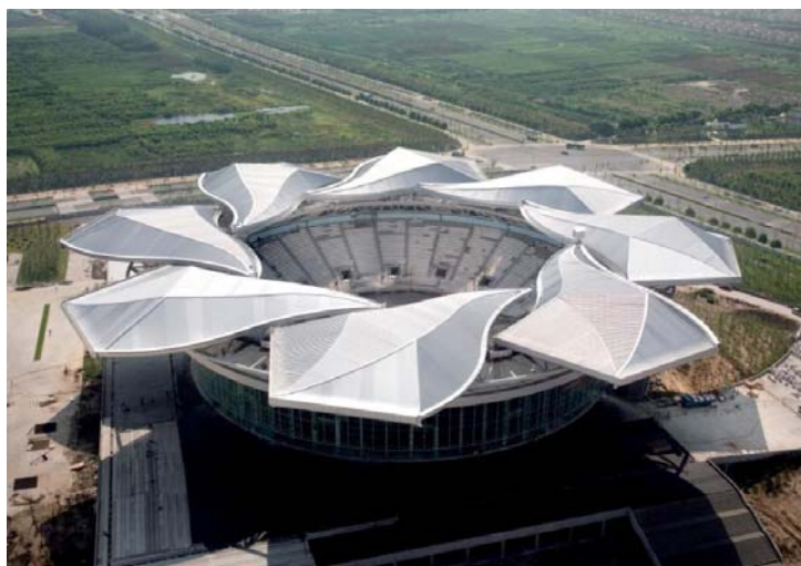
Рис. 4. [8] – Трансформация крыши, напоминающей очертания цветка магнолии. Стадион Чи Джонг, г. Шанхай, Китай, 2005 г.
