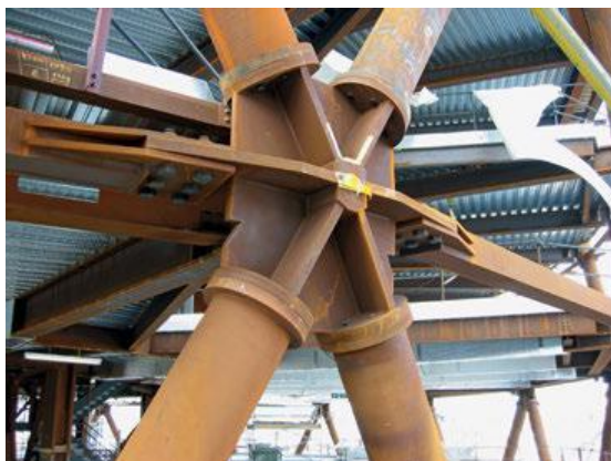
Рис. 10. – Типовой узел здания Swiss Re
