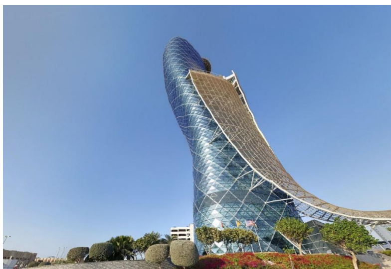
Рис. 8. – Пример криволинейной архитектурной формы с системой Diagrid.
