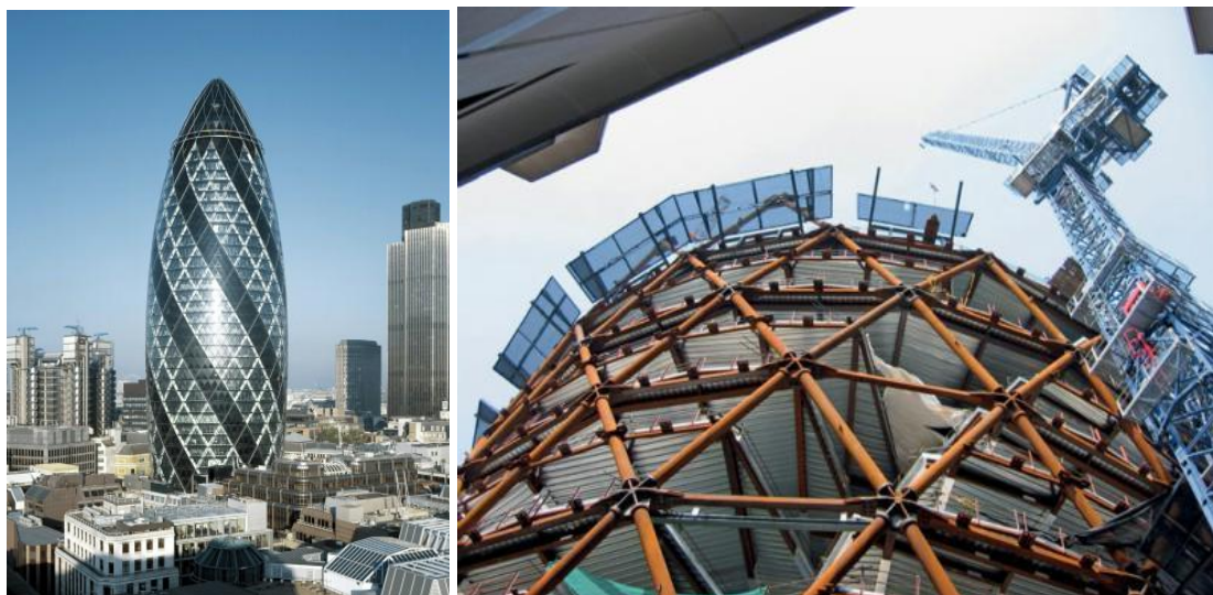
Рис. 5. – Здание Swiss Re. Слева готовое здание, справа - оно же во время строительства [3].
