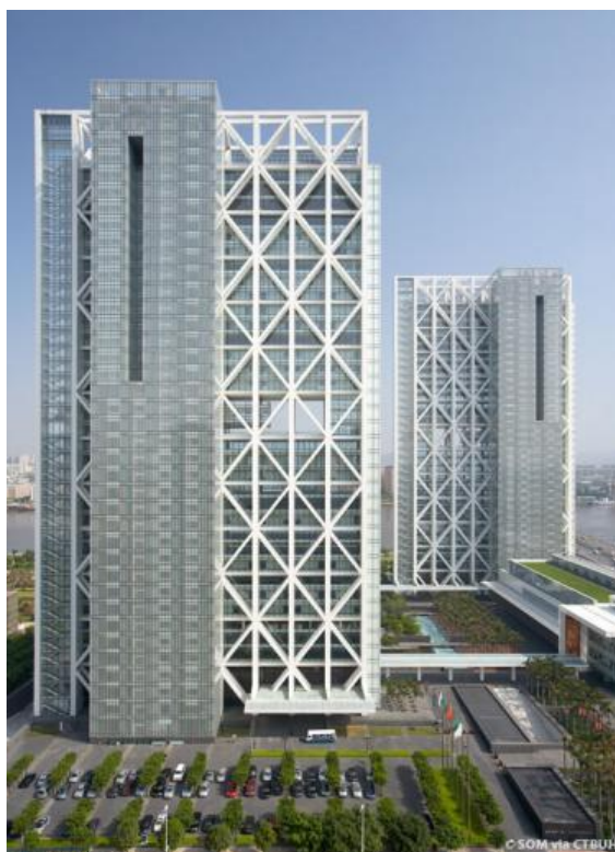
Рис. 6. – Poly Real Estate Head-quarters – здание с элементами Diagrid, выполненными из железобетона.
