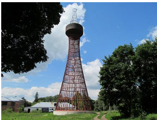
Рис. 1. – Первая в мире водонапорная башня с несущей конструкцией в виде сетчатого гиперboloида, представленная на Всероссийской выставке 1896 г., настоящее время.
