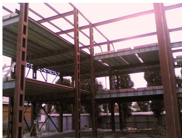
Строительство торгового центра в г. Майкоп.
