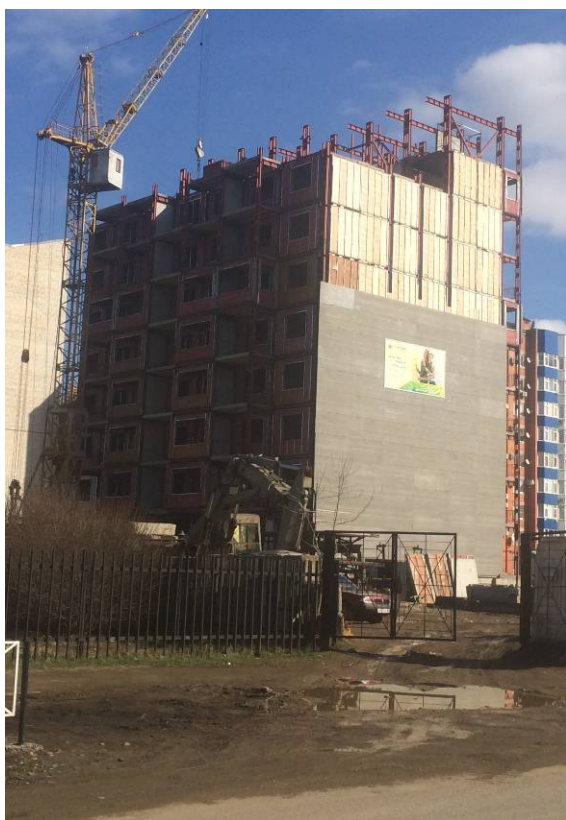
Строительство жилого дома в г. Майкоп.
