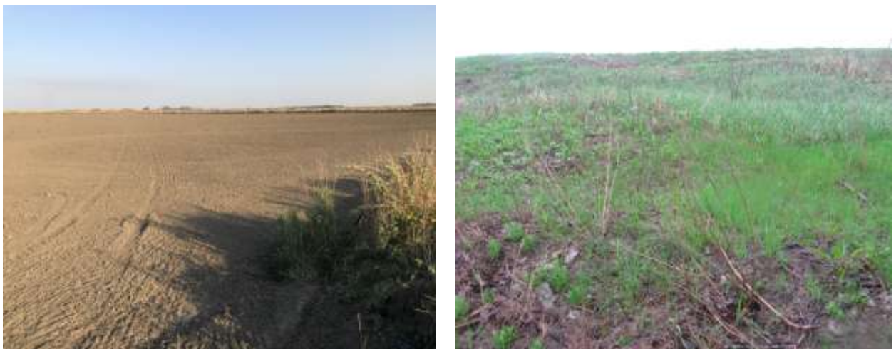
Рисунок 3 - Процессы эрозии на сооружениях внутрихозяйственной сети рисовых оросительных систем: а) образование ложбин на рисовом чеке; б) образование оползня на низконапорной дамбе.
